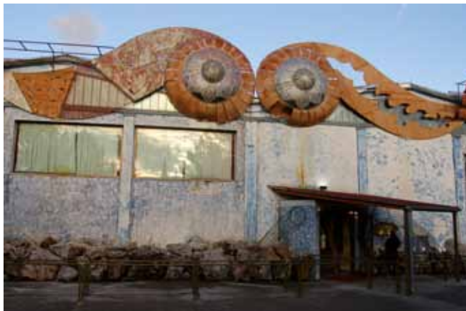
ISOLA: gli esterni della discoteca Gavioli
