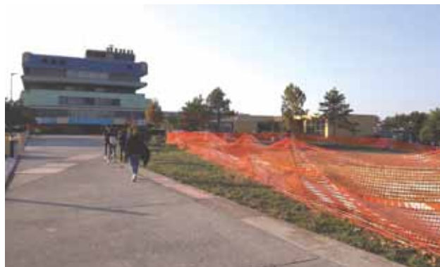
ISOLA: I lavori per l'eliporto
