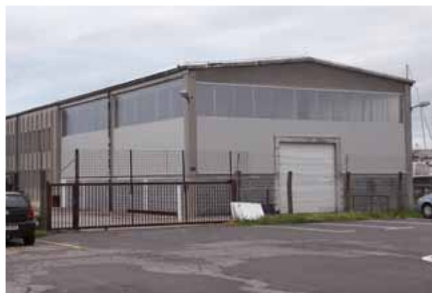
ISOLA: Il capannone vicino al cantiere
