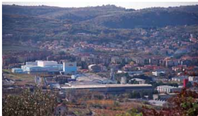
ISOLA: Zona industriale
