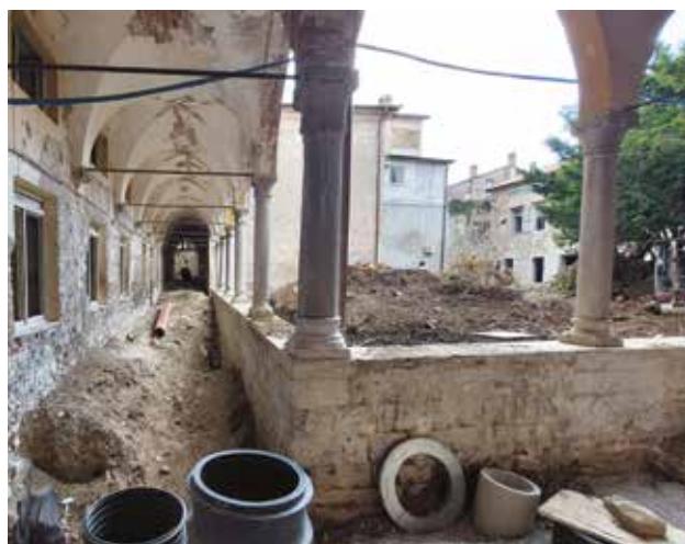
CAPODISTRIA: I lavori nel chiostro
