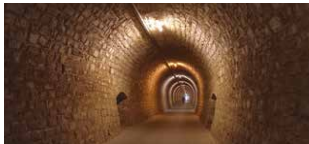
ISOLA: Il tunnel a Valeta
